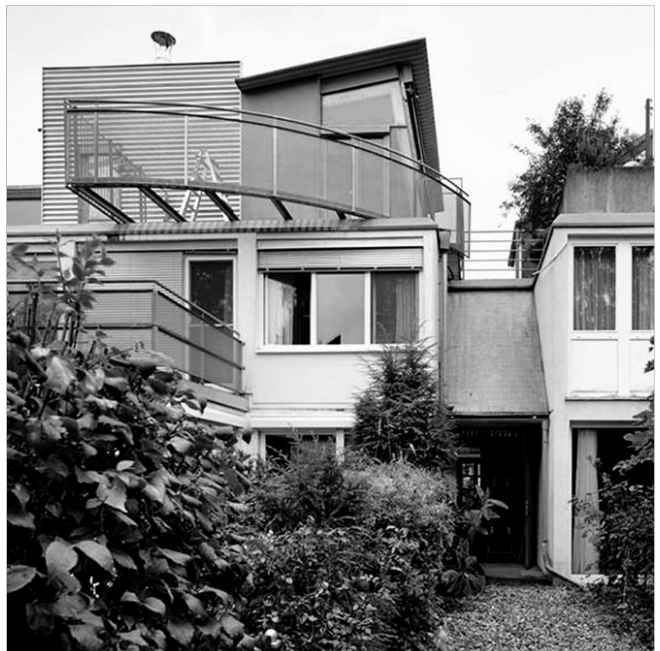
'Dakhuisje' op de bovenste verdieping
