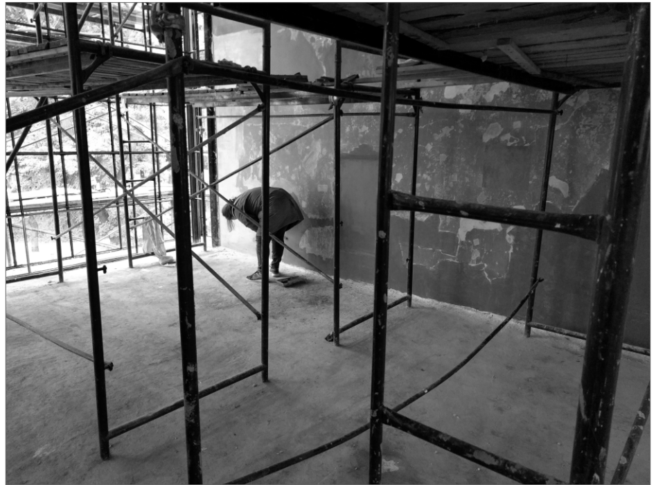
Het restaureren van de oorspronkelijke verflaag in het restaurant
