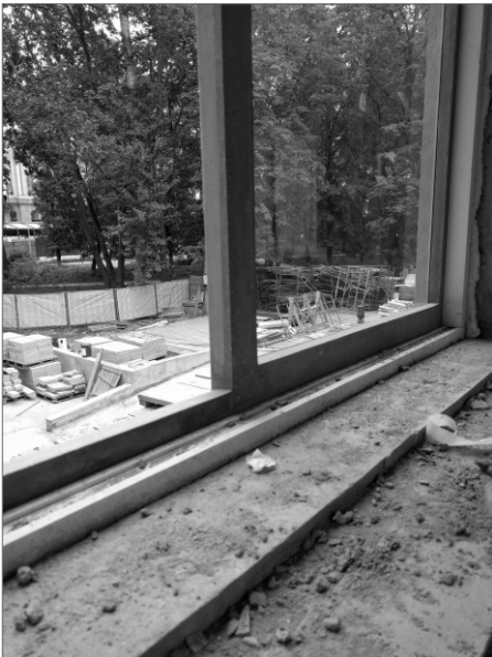
Boven de metalen kozijnen, onder de betonnen kozijnen in 2019
