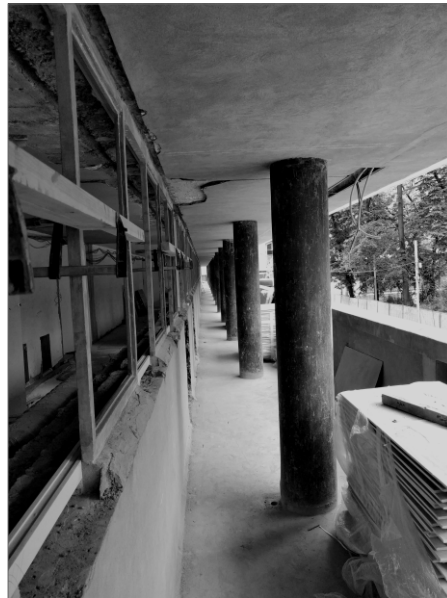
Balkon tijdens de restauratie in 2019
